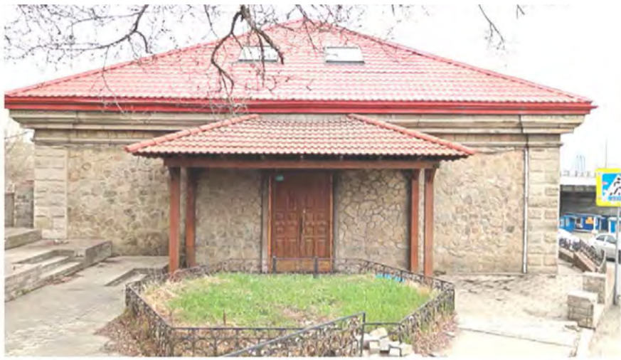
Северный (торцевой) фасад здания
