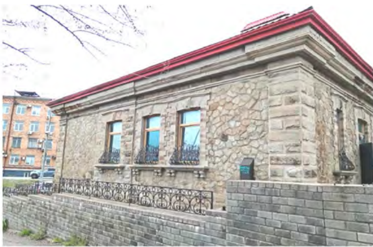
Южный (торцевой) фасад здания
