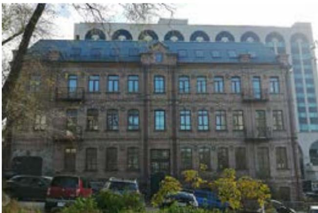
Архитектурная композиция фасада симметрична. По горизонтали сформирована лопатками, раскреповкой в центральной части и равномерным размещением оконных и балконных проемов, по вертикали - профилированными междуэтажными поясками, венчающим карнизом.
