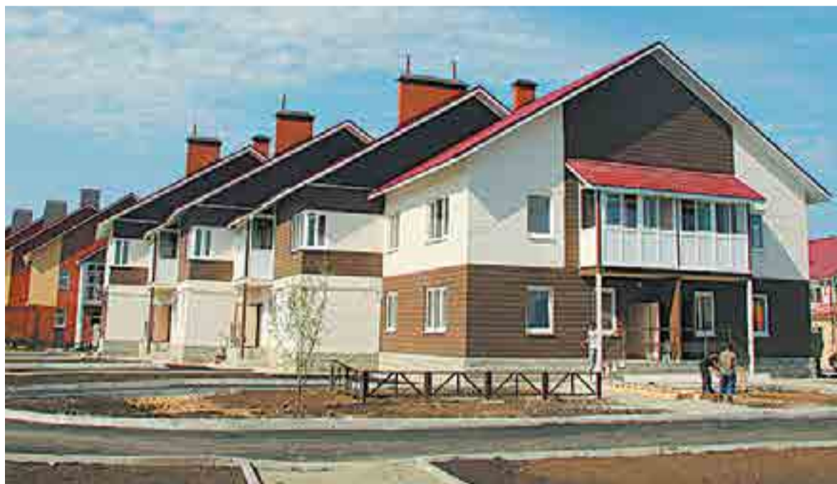
В НОЯБРЕ К ЗЕМЕЛЬНЫМ УЧАСТКАМ МНОГОДЕТНЫХ СЕМЕЙ ДОЛЖНА БЫТЬ ПОДВЕДЕНА ИНЖЕНЕРНАЯ ИНФРАСТРУКТУРА. ФОТО EKBURG.RU
